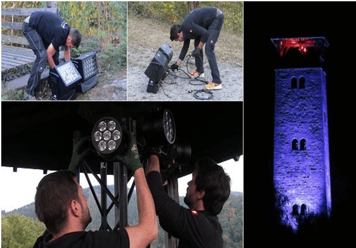
Abbildung 18: Installation der Beleuchtung des Ohrsbergturms im Oktober 2018, (RICHTER 2018)
