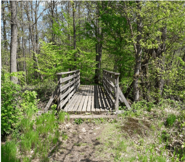
Abbildung 16: Holzbrücke über den zweiten Ringwall von Royal Engineers 2005 gebaut, Foto: S. Wien, 30.04.2019
